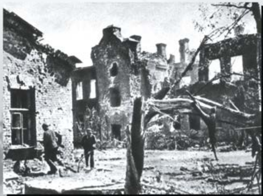
Разрушенный г. Брест
